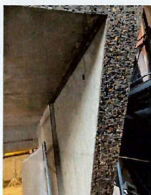
Sichtbeton front bei Tiefgarage
