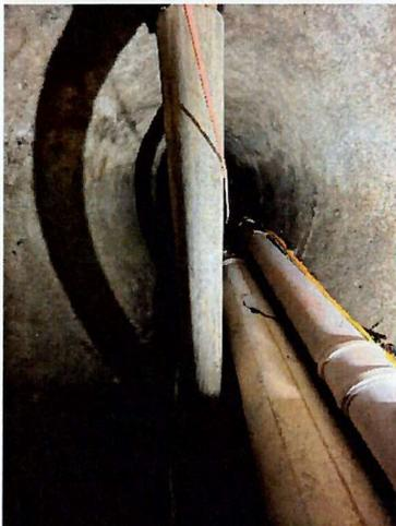
Durch den Kanal verlegte Wasserrohre sowie über die gesamte Länge eine Holzspriessung alle 1.5m.
