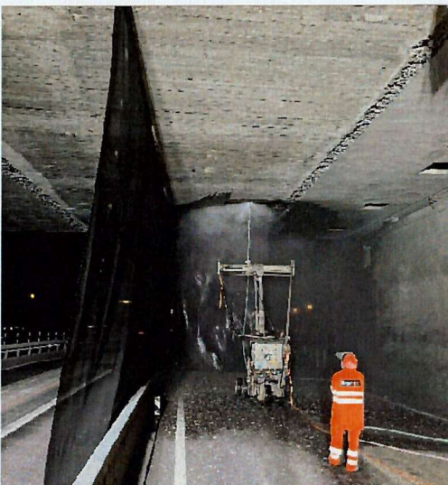
Überkopfabtrag auf 5.5m unter Brücke
