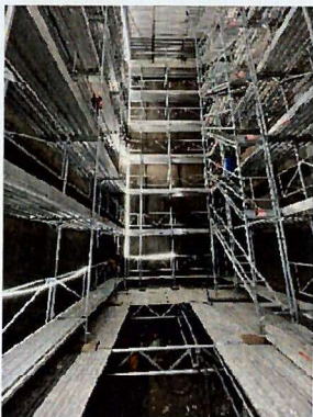
Baugerüst inkl. Metalldeckel (Da Verbrennungsanlage weiterhin in Betrieb war)
