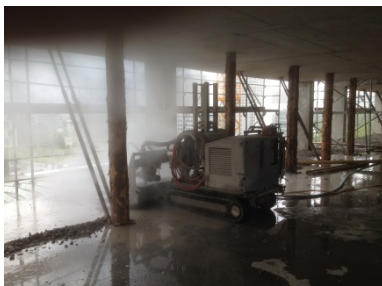
Randarmierung freilegen zwischen Notsprissungen
