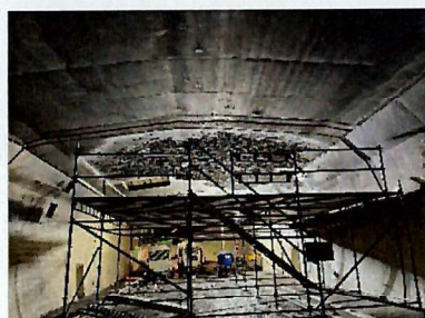
Baugerüst für die bearbeitung
