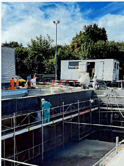
Beschichtung entfernen mit der Handlanze
