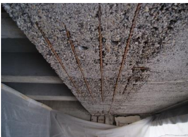
Korkisoliationsplatten entfernen mit Rotordüsen
