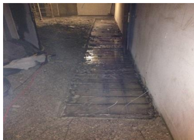
Schlitz mit Eisen freilegen bis 12 cm Tief Im 2.UG bis 80 cm Tief
