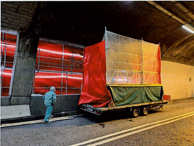
Gerüstanhänger für die Bearbeitung des Pfeilers
